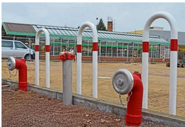
In der Samtgemeinde Brome werden die Löschwasserbrunnen erneuert. SYMBOLOFOTO: ARCHIV
