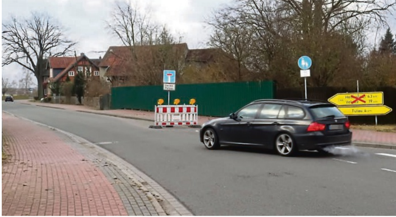
Eigentlich ist schon in Croya alles gesagt – in Parsau wartet eine Baustelle. Für den Durchgangsverkehr ist die Strecke gen Rühren gesperrt. Daran halten tun sich viele allerdings nicht.
