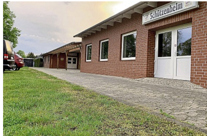
Das Schützenhaus Lessien soll saniert werden, der Plan hat weiter Bestand. Bürger sollen mitreden.
